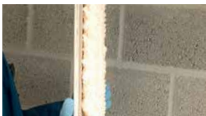
Verlijmen van gipskarton
