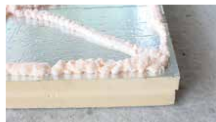
Verlijmen van isolatieplaten
