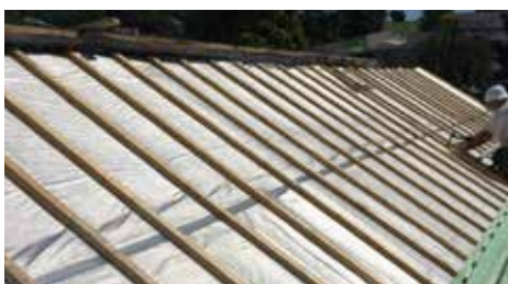
Hellend dak afwerken: buiten
