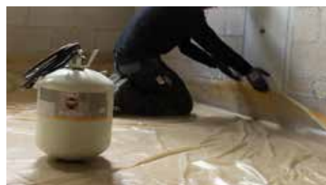
Bij chape & pleisterwerken
