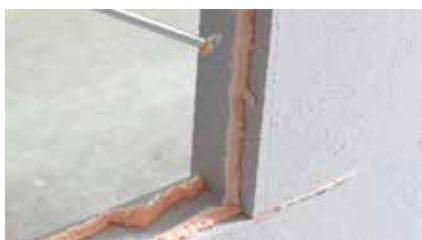
Verlijmen van cellenbeton
