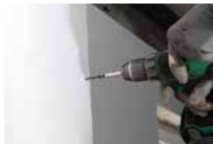
8. Kopse plaat vastschroeven aan de houten balk rechts
