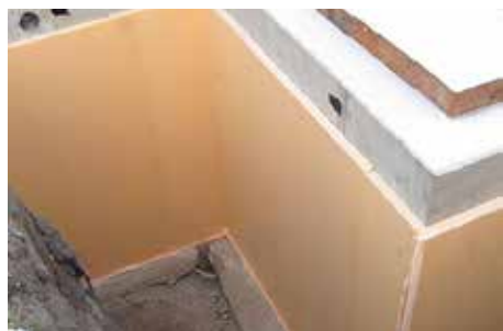
5. Aansluitingen hoeken afwerken.
