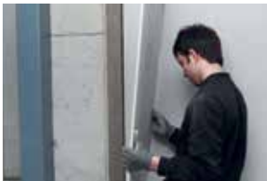
4. Plaat op zijn plaats zetten en aanduwen
