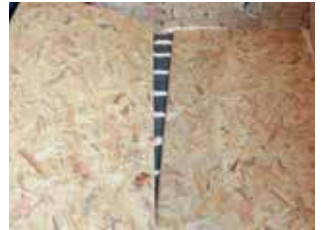
6. Klik de platen in elkaar en druk stevig aan. Loop niet over de platen tot na uitharding van de lijm.
