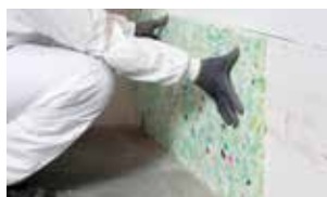
3. Tegen de ondergrond plaatsen en 1 min vasthouden.
