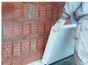
5. Plaat op zijn plaats brengen.
