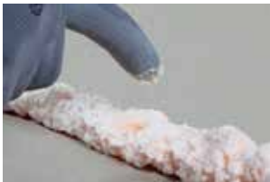
Lijmlaag barst open bij aanraking: te vroeg
