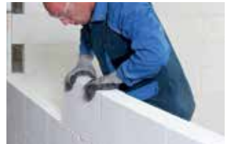
9. Plaats de steen in de lijmlaag
