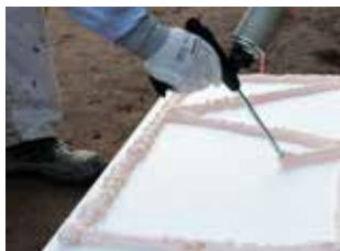
4. Easy Fix aanbrengen op de plaat en ca. 5 min wachten.
