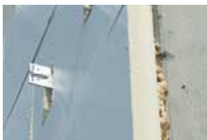
Buitengevelisolatie achter gevelpanelen
