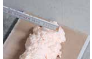
lijmstreng \emptyset min. 5 cm oneffenheid uitvlakken (max. 2 cm)
