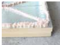
Verlijmen van isolatieplaten
