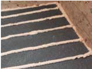
4. Lijm de isolatieplaten in.
