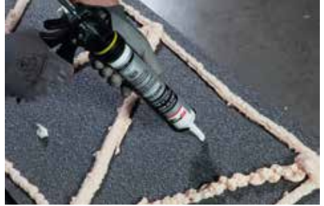
2. Plaats tussenin dotten montage lijm met hoge aanvangshechting.
