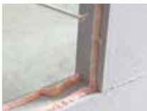
Verlijmen van cellenbeton
