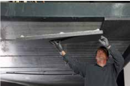
3. Bevestig de plaat na 5 min.
