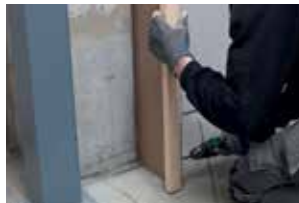
5. Schroef een balk links van de plaat
