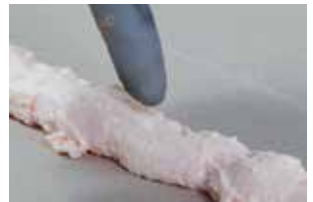
Velvorming: lijm voelt droog aan: te laat. Opnieuw lijm aanbrengen
