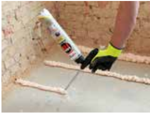
1. Plaats de lijmrillen op de ondergrond.
