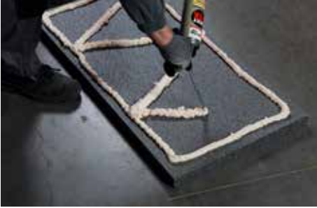
1. Breng de lijm aan in zigzag vorm.
