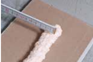
lijmstreng \emptyset 1 à 2 cm vlak op vlak verlijming
