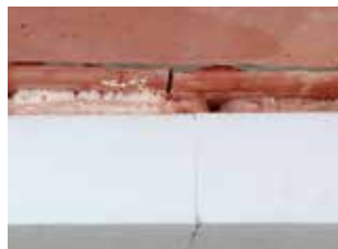
6. Controleer of er voldoende contact is met ondergrond.
