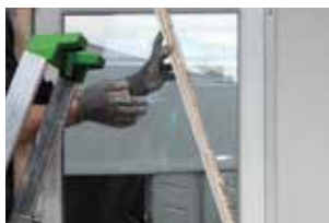
8. Steunbalk plaatsen en zijkant 2
