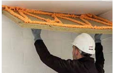
2. Plaat aanbrengen binnen 2 min.
