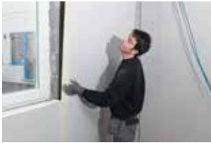
4. Plaat op zijn plaats zetten en aanduwen
