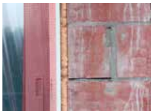
1. Profielen en aansluitingen moeten geplaatst zijn.
