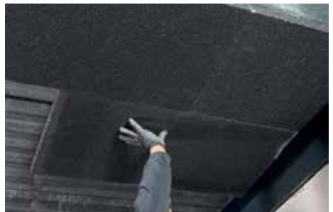
6. De volgende plaat kan er onmiddellijk naast geplaatst worden.
