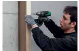
6. Bevestig de balk onder- en bovenaan aan de plaat
