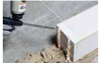
6. Kimblokken mogen verticaal opgevoegd worden
