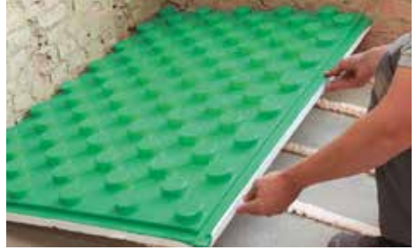
2. Plaat aanbrengen in de lijmlaag.
