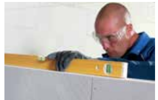
12. Controleer de pasheid na elke laag
