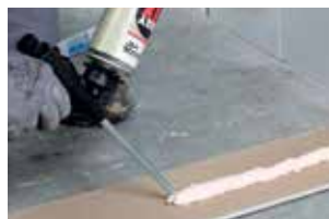
6. Pistool opendraaien en plaat inlijmen
