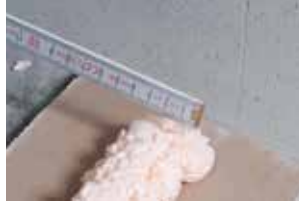
lijmstreng \emptyset 3 à 4 cm oneffenheid uitvlakken (max. 1 cm)
