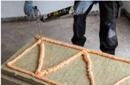
1. Breng de lijm aan in zigzag vorm.
