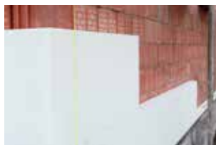
Buitengevelisolatie met afwerkingspleister
