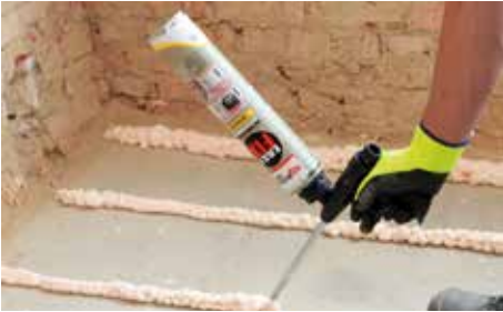
1. Easy Fix aanbrengen op ondergrond.
