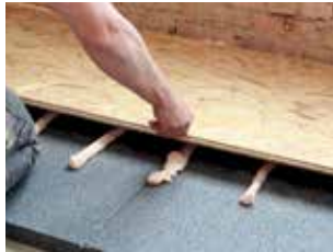
5. Plaats de ondervloer haaks op de isolatieplaten.
