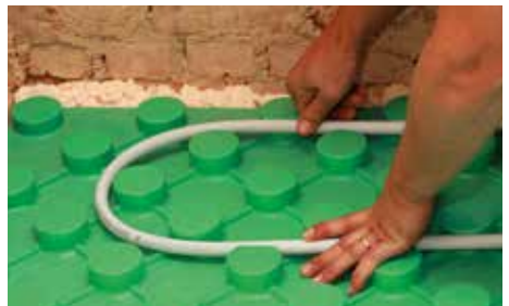
6. Na 1u kan het buizensysteem reeds aangebracht worden.
