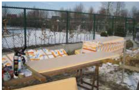
2. Platen verlijmen.
