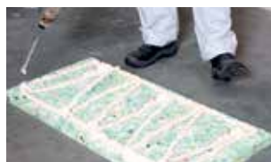
1. Plaat inlijmen met Easy Fix.
