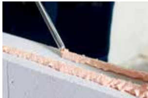
8. Breng 2 evenwijdige lijms- strengen aan
