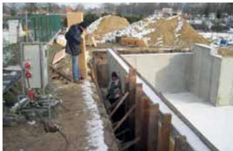
3. Platen op zijn plaats brengen.
