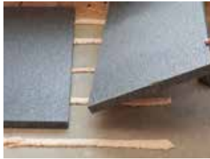
2. Plaats de isolatie loodrecht op de lijmrillen. Druk stevig aan.
