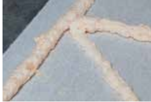
2. Goed aansluiten, wachten tot de lijm draden trekt.
