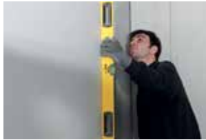
5. Waterpas controleren en bijduwen waar nodig
